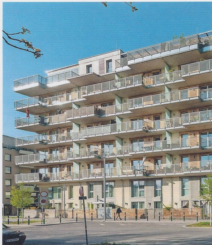
Das Passivhaus Eurogate BPL 7 in 1030 Wien zeigt die vielfältigen Möglichkeiten der Bauweise auf.
